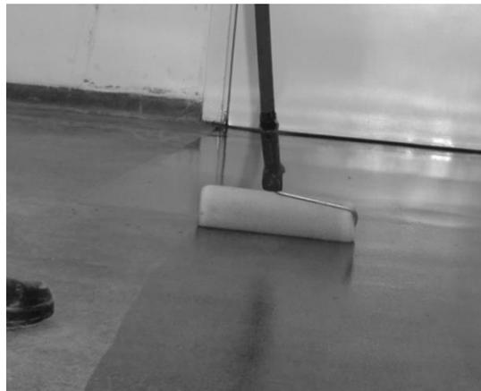
3. **Massa autonivelante:** Aplicação de massa niveladora homologada pela Baueco, com espessura final máxima de 3mm, com o objetivo de se obter uma superfície perfeitamente lisa, nivelada e preparada para a aplicação do adesivo. O tempo médio de secagem do composto autonivelante é de 18 horas. Após secagem, o piso deverá ser novamente lixado (lixa grão nº 32), em seguida limpo com aspirador para remoção da poeira;
